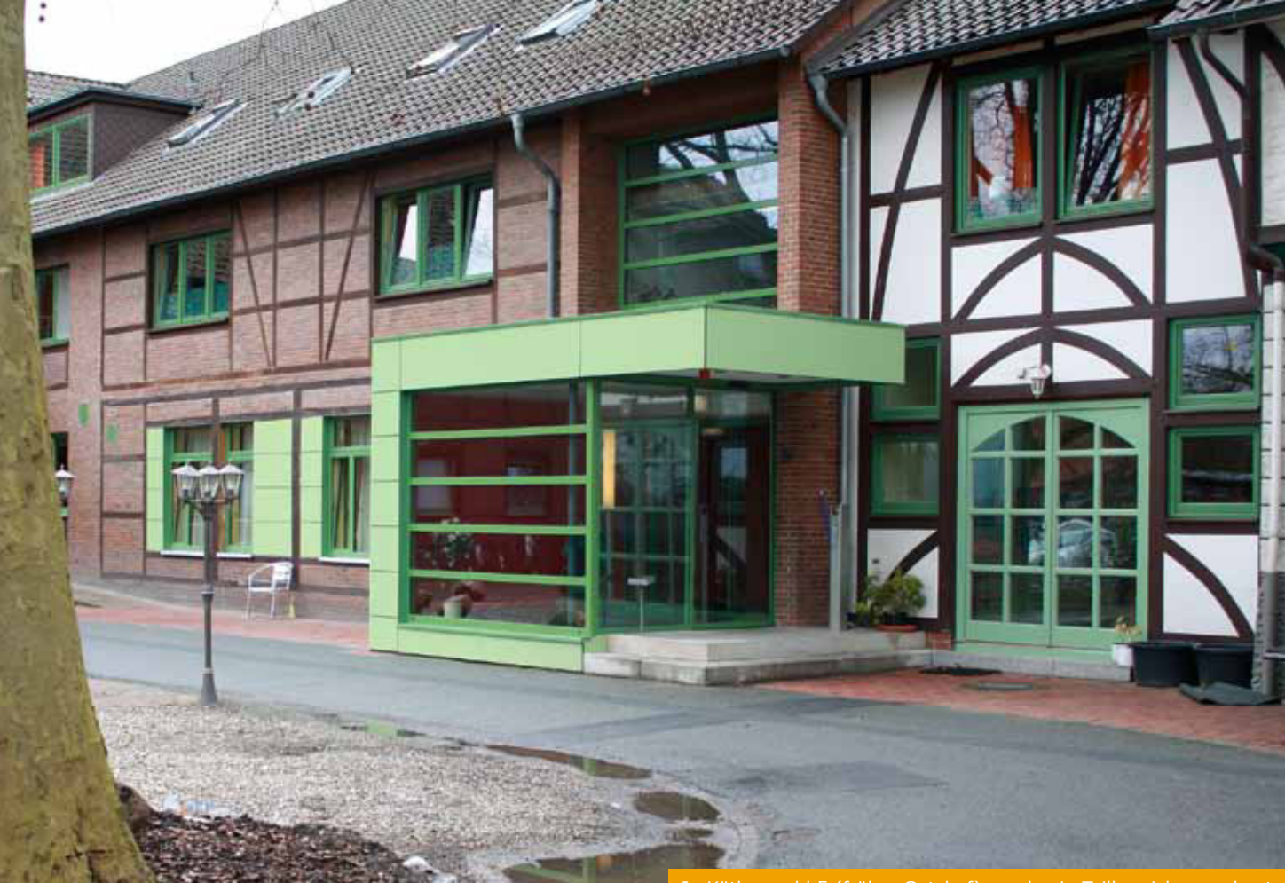
In Köthenwald 5 (früher Gutshof) wurde ein Teilbereich umgebaut
